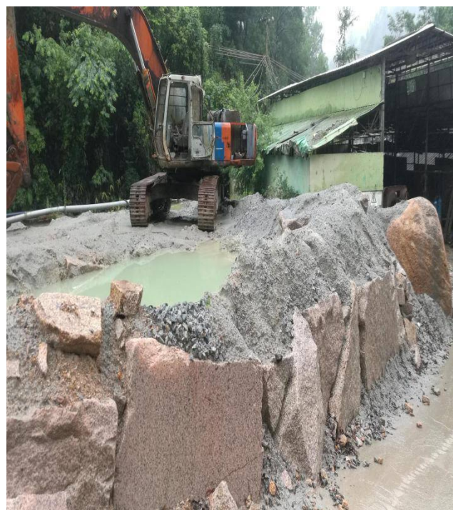
照片 8 机修车间旁水池
