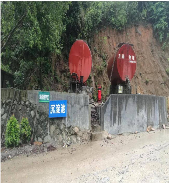
照片 3 道路边水泥砌筑沉淀池
