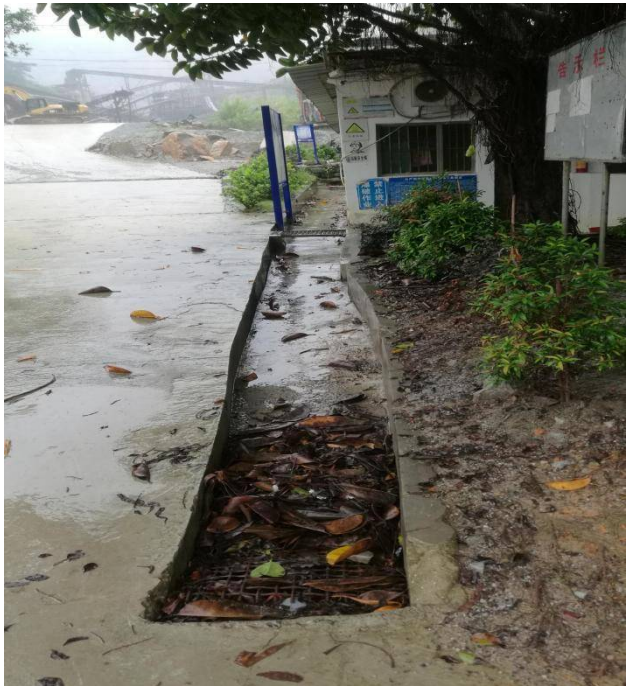
照片 2 道路绿化及排水沟
