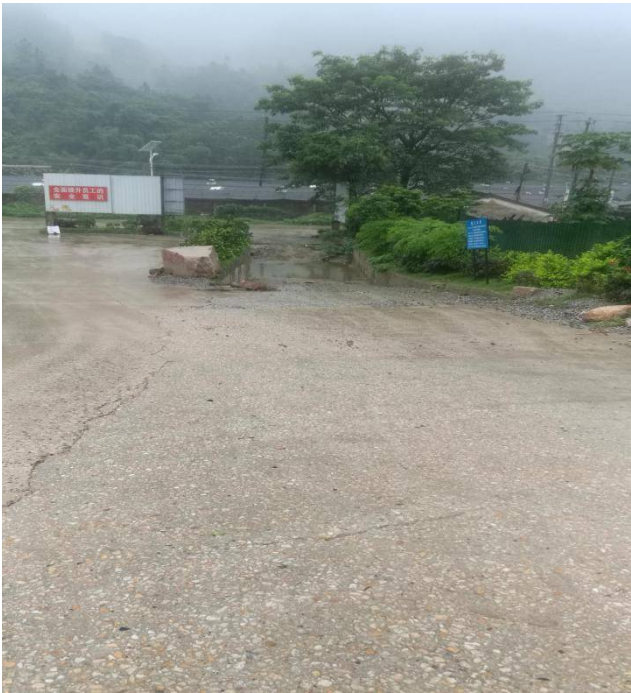
照片 1 道路硬化及洗车池
