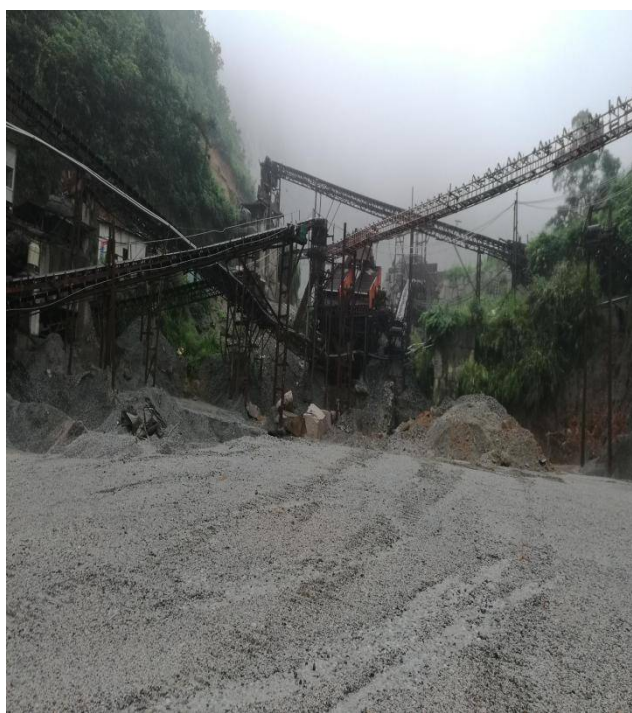
照片 7 工业场地现状
