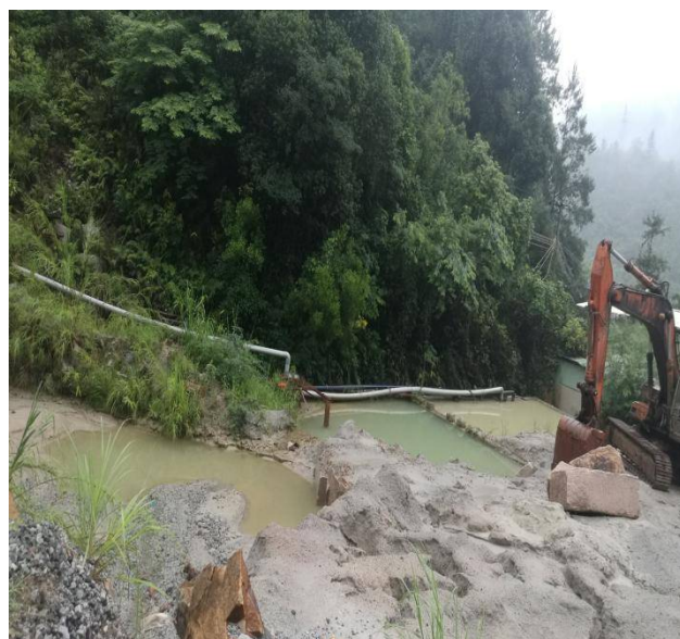
照片 6 三级跌水兼沉砂池
