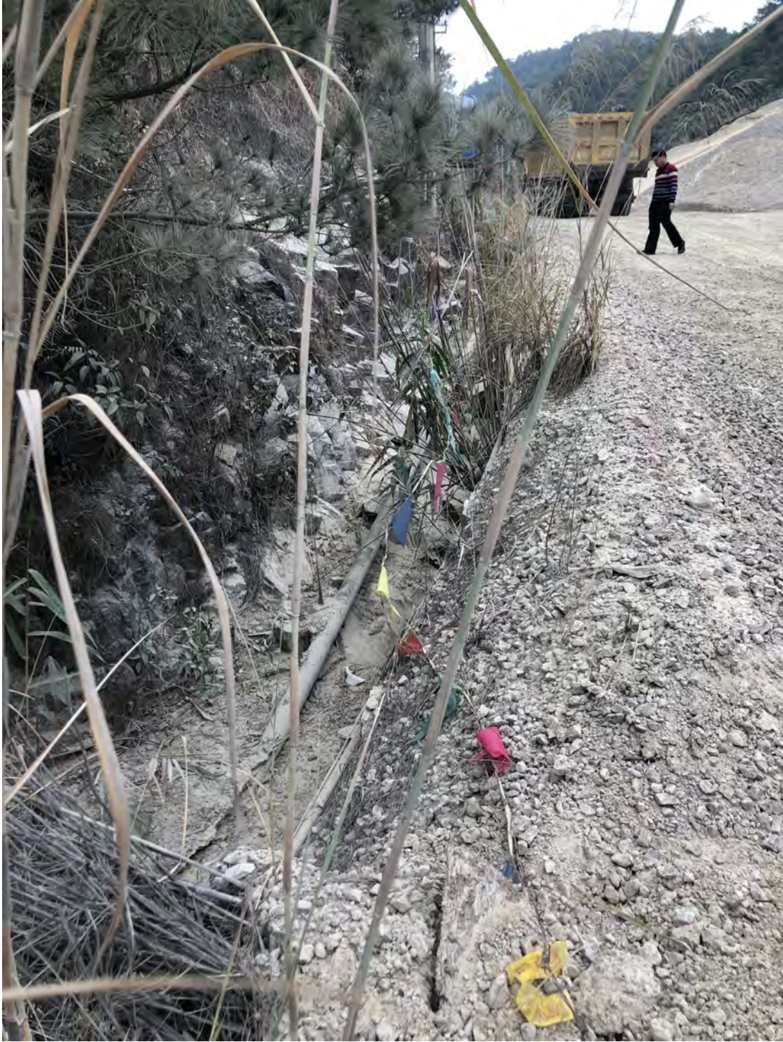
图 7：矿山道路排水沟
