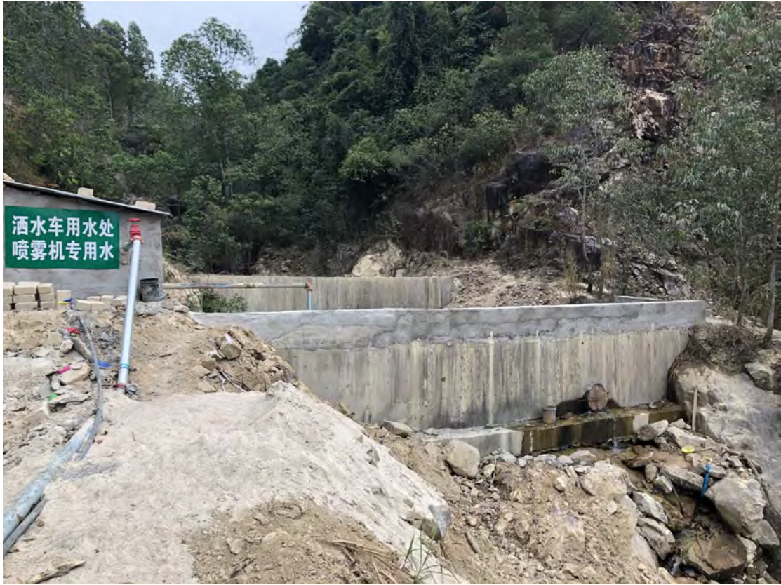
图 5：矿山道路沉砂池 2
