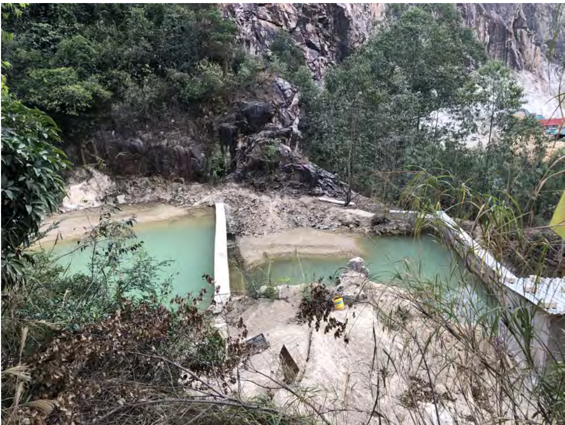
图 4：矿山道路沉砂池 1
