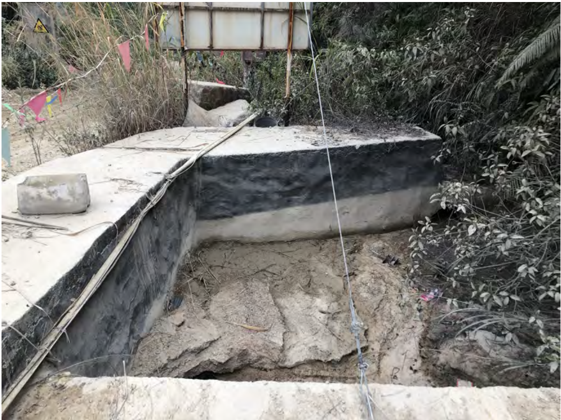
图 6：矿山道路沉砂池 3
