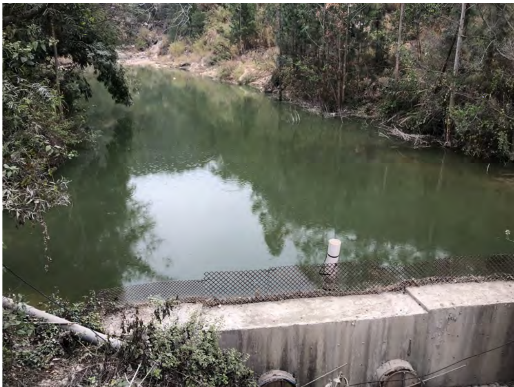
矿区下游坑塘（沉淀池）
